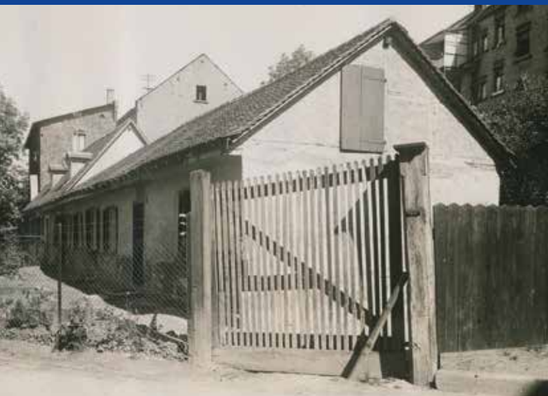
Haus des Landwirts Albert Heß, Hohler Weg 5, vor dem Abriss im Jahr 1927
