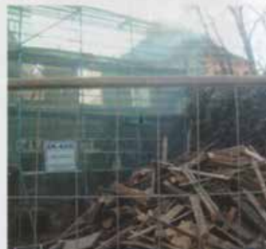
Eine Meisterleistung vollbrachte das Abrissunternehmen, das Hinterhaus Lauteschlägerstr. 19 ohne Schäden für das Achteckige Haus abzureißen und den Abtransport durch die enge Toreinfahrt zu organisieren.
