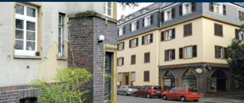
Bellevue-Block an der Barkhausstraße - vor und nach der Sanierung
